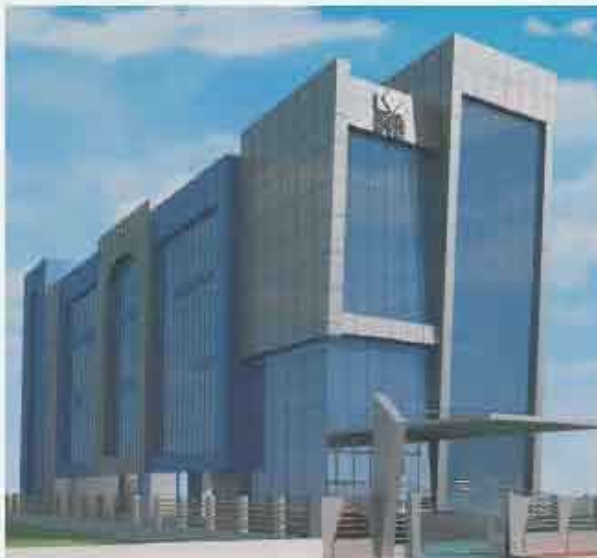
गिंडी इंस्टिट्यूट ऑफ बैंकिंग एंड फाइनेंस, चेन्नै में बन रहा, एसटीसी, चेन्नै शाखा का नया भवन
